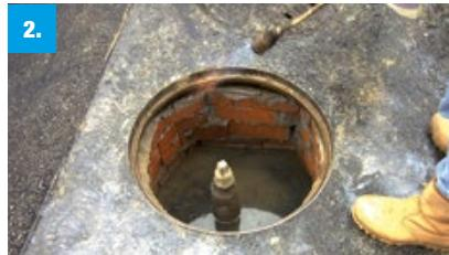
**Trocknen:** Anschließend den Bereich mit der Gasflamme trocknen.
