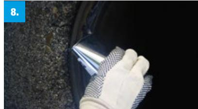
**Ausgießen:** Nach dem Anmischen wird die Masse gleichmäßig auf den Auflagerand verteilt.
