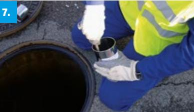
**Verrühren:** Beide Komponenten nun mit beigelegtem Rührstab gut durchmischen (ca. 60 Sekunden). Topfzeit des Materials bei 23°C (73,4°F): ca. 4 min. Bei steigenden Temperaturen wird die Topfzeit kürzer.
