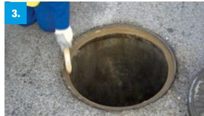
**Rost entfernen:** Danach die Oberfläche des Auflagerandes mit einer Stahlbürste von Flugrost befreien und anschließend trocken abwischen.
