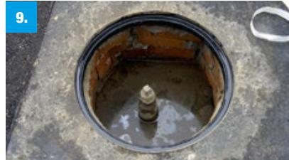
**Austrocknen lassen:** Je nach Witterung und Temperatur ca. 10 – 20 Minuten warten, bis die Masse angetrocknet, aber noch nicht durchgehärtet ist (Fingerprobe!).
