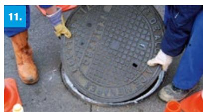
**Deckel aufsetzen:** Danach den Schachdeckel aufsetzen. Zu beachten ist hierbei das richtige Timing zwischen dem Aufbringen der Masse und dem Auflegen des Deckels, um den gewünschten Effekt zu erzielen.
