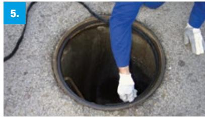
**Schalung anbringen:** An den Innenrand der Deckelauflage TOK®-Band SK 25 x 8 mm mit ca. 3-4 mm Überstand ankleben.
