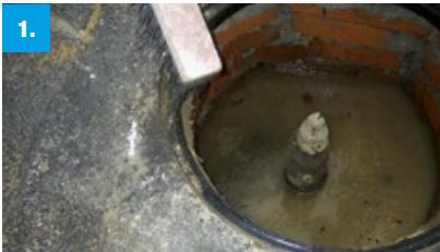
**Reinigen:** Nach dem Öffnen des Kanaldeckels Auflagerand von grobem Schmutz befreien.
